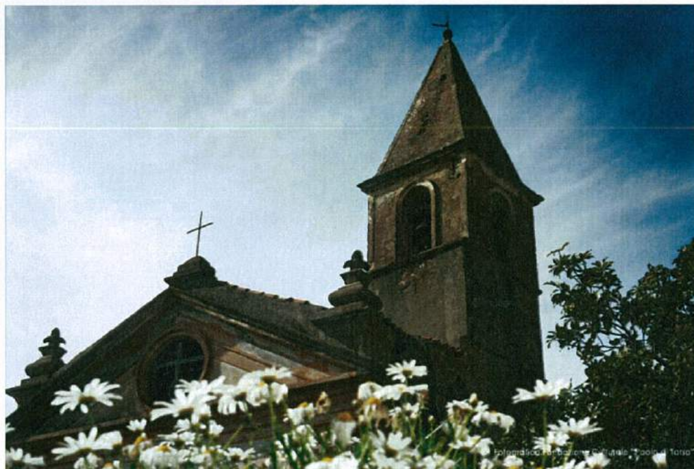
Dettaglio del campanile della Chiesa in Via San Francesco di Paola
