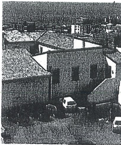
Il complesso Sant'Agostino
